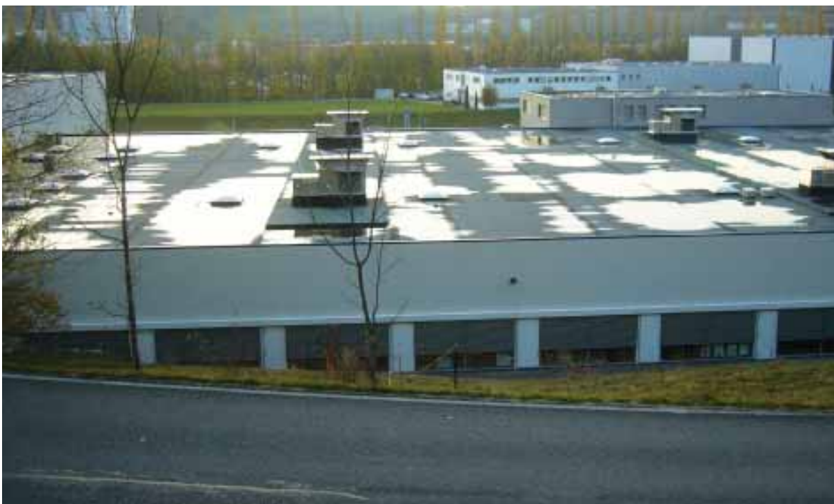
Toiture nue sans pente
