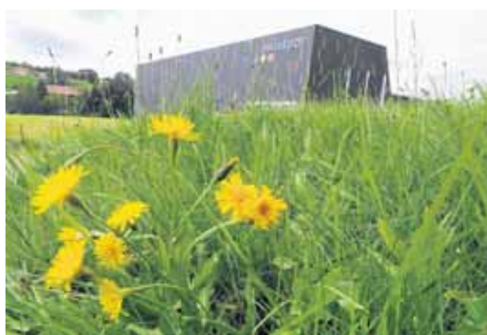
Der Neubau fñgt sich laut dem Architekten ins Gelände ein. Bild vrn
